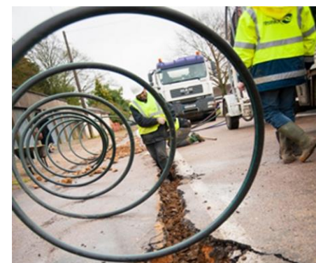
Déploiement d'un réseau de fibre optique Source : S. Bachelot @cg27/ 2014
